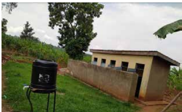
Toilet at Ngarama H/C III
